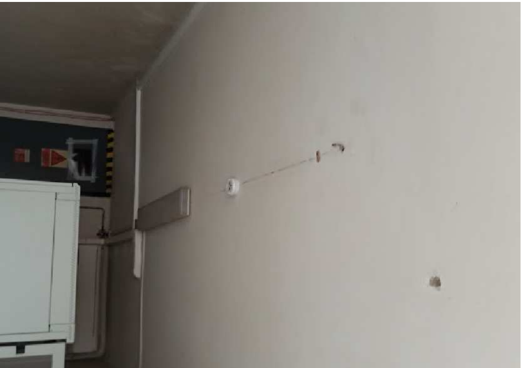
STÁVAJÍCÍ ČIDLO EPS ZACHOVAT, NOVĚ NAPOLIT ČIDLO Z PROSTORU MANIPULAČNÍ PLOCHY
